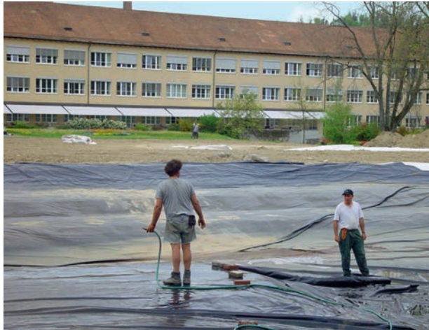
Teichbau auf der Tiefgarage
