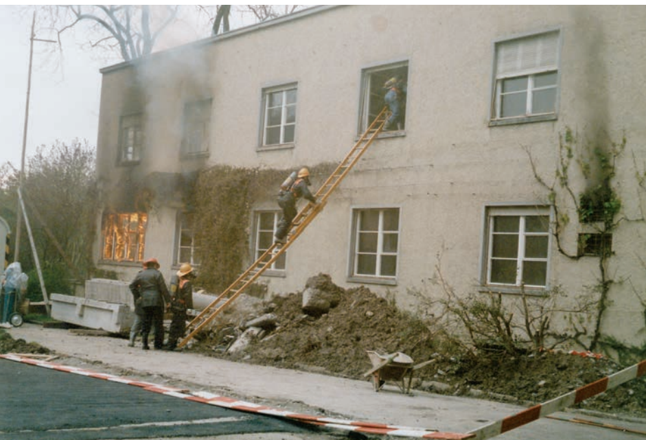
«Heisser Abbruch» des Operationstraktes
